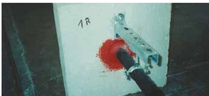
Testmodul Hilti Brandschutzdichtmasse.
