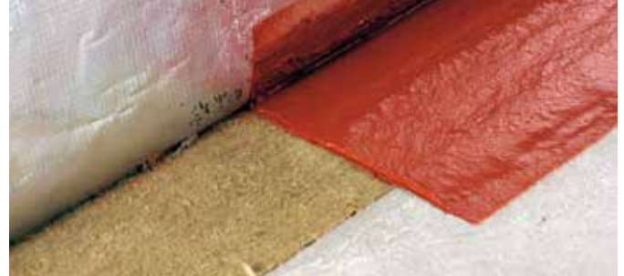
① Fuge Außenwand (Fassade) zum Boden.
