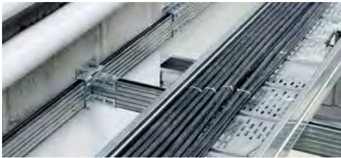
Verlegung von Kabeln.
