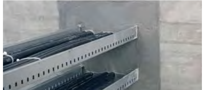
Abschottung sehr großer Durchführungen mit Brandschutzmörtel CP 636.
