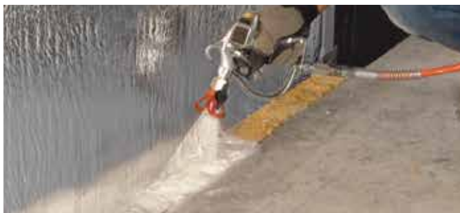
Brandschutzspray CFS-SP WB.
