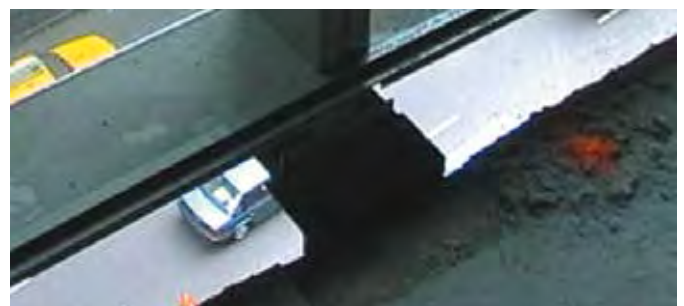
Offener Spalt zwischen Fassadenelement und Decke.
