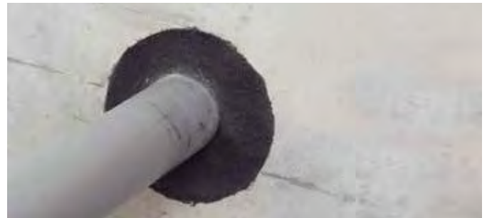
Verschluss mit Brandschutzmasse CP 611A.
