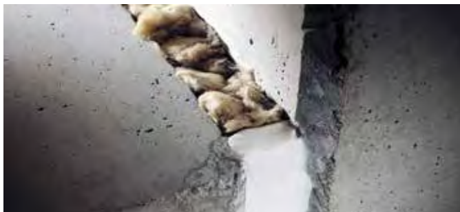
Elastische Brandschutzdichtmasse CFS-S SIL, Brandschutzfugenfüller CFS-S ACR.
