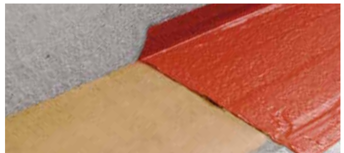
④ Fuge Wand zum Boden.
